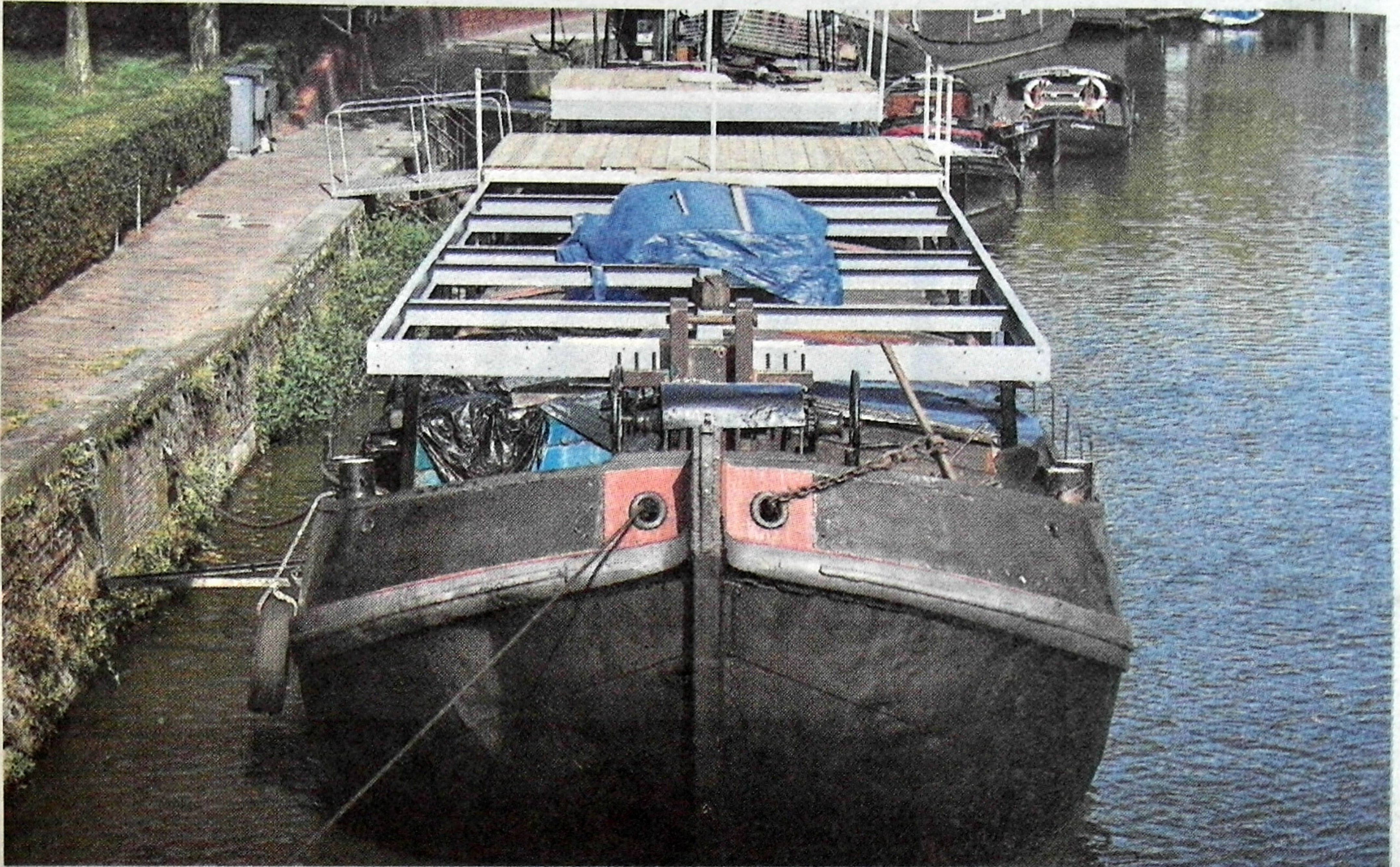
▲ De stalen constructie voor het terras is gemonteerd op het dek van de woonboot. Foto Siese Veenstra
